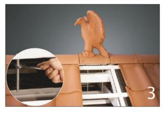
Der Adler wird mit zwei Muttern inkl. Unterlegscheiben unterhalb der Firstpfette verschraubt. Die Gewindestangen können bei Bedarf gekürzt werden.
