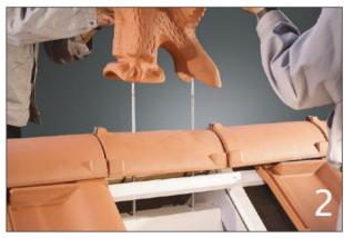
Die Gewindestangen werden handfest in die Füße des Adlers in hierfür vorgesehene Aufnahmen eingedreht. Der Adler wird mit den Gewindestangen auf den Firstziegel aufgesetzt.
