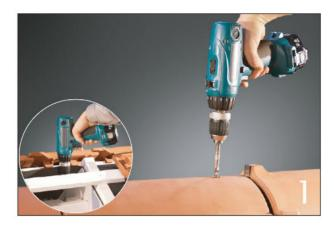
Durch Firstziegel und Firstpfette müssen zwei Löcher im Abstand der Gewindestangen gebohrt werden.
